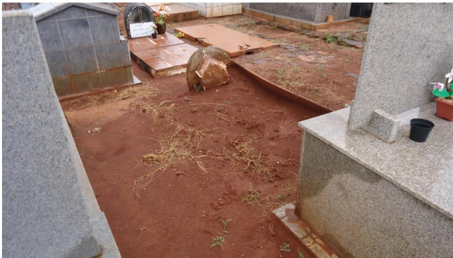
Figura 7: Sedimentos carreados no interior do cemitério.
