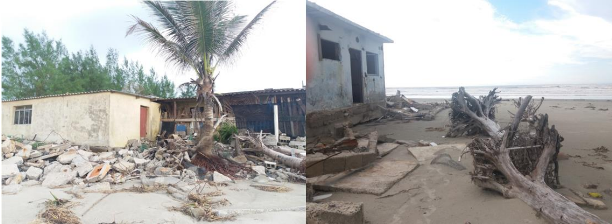
Figura 4 - Edificações destruídas pelo avanço do mar na Ponta da Praia Norte no Município de Ilha Comprida. Fonte: Arquivo dos autores (2017)
