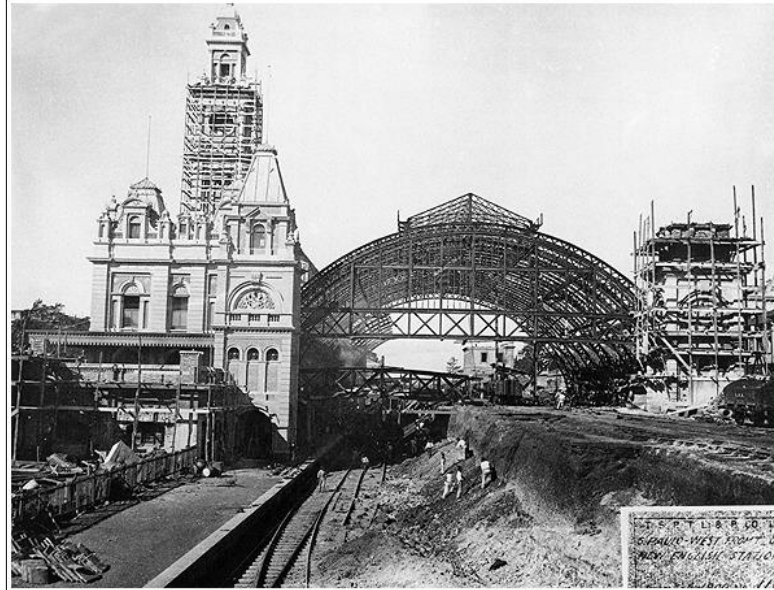
Figura2 – Construção da atual Estação da Luz (início do séc. XX)
