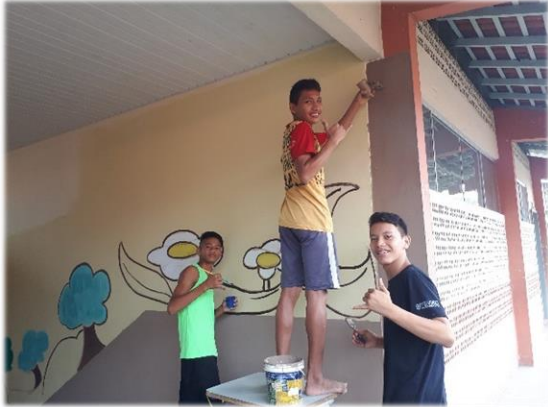
Figura 7: Escadaria do Bloco B sendo revitalizada. Fonte: Projeto “Do espaço real ao lugar ideal”, 2018.
