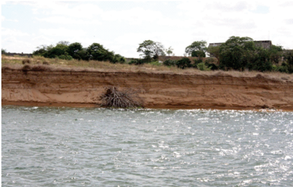
Imagem 9 – O Velho Opará em ruínas. 20 de Janeiro de 2018.
