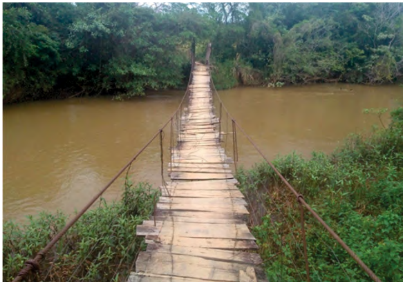
Imagem 1 – Ponte do Rio Corrente
