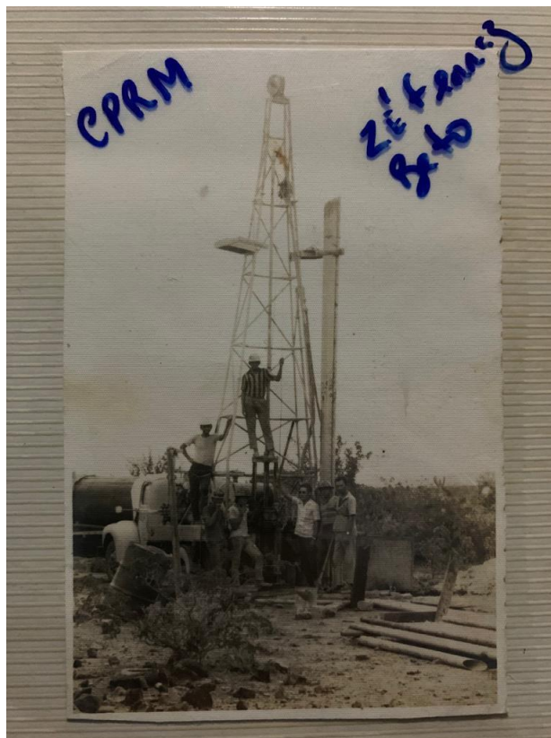
Figura 2 Máquina de cavar poço Fonte: Zé Ferraz
