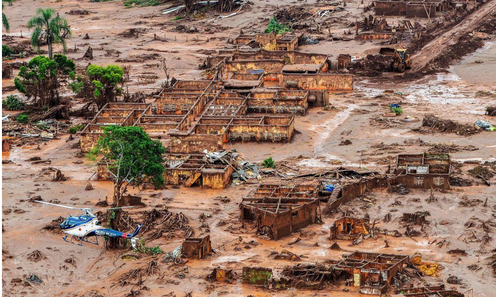
Figura 2 Destruição provocada pela lama em Brumadinho (MG).
