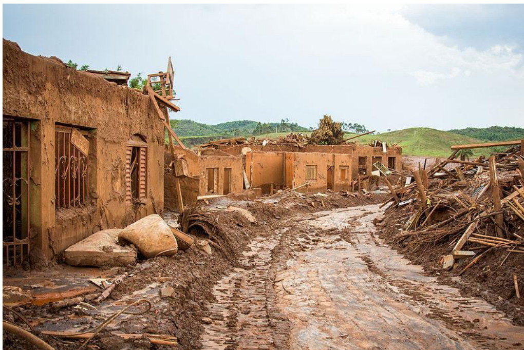
Figura 1 Destruição provocada pela lama em Bento Rodrigues, Mariana (MG). Fonte: Romerito Brito (2015).
