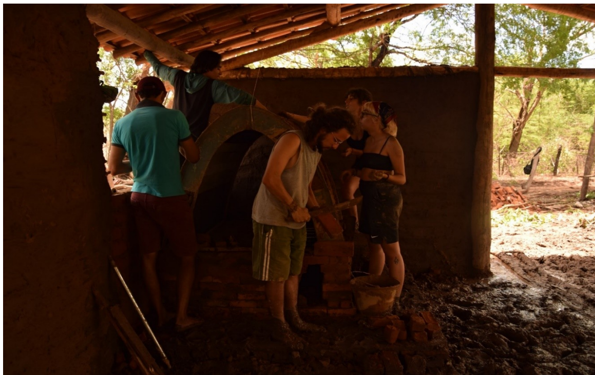
Figura 1: Construção do Forno de Cerâmica. Foto de autoria de Pedro Arles.
