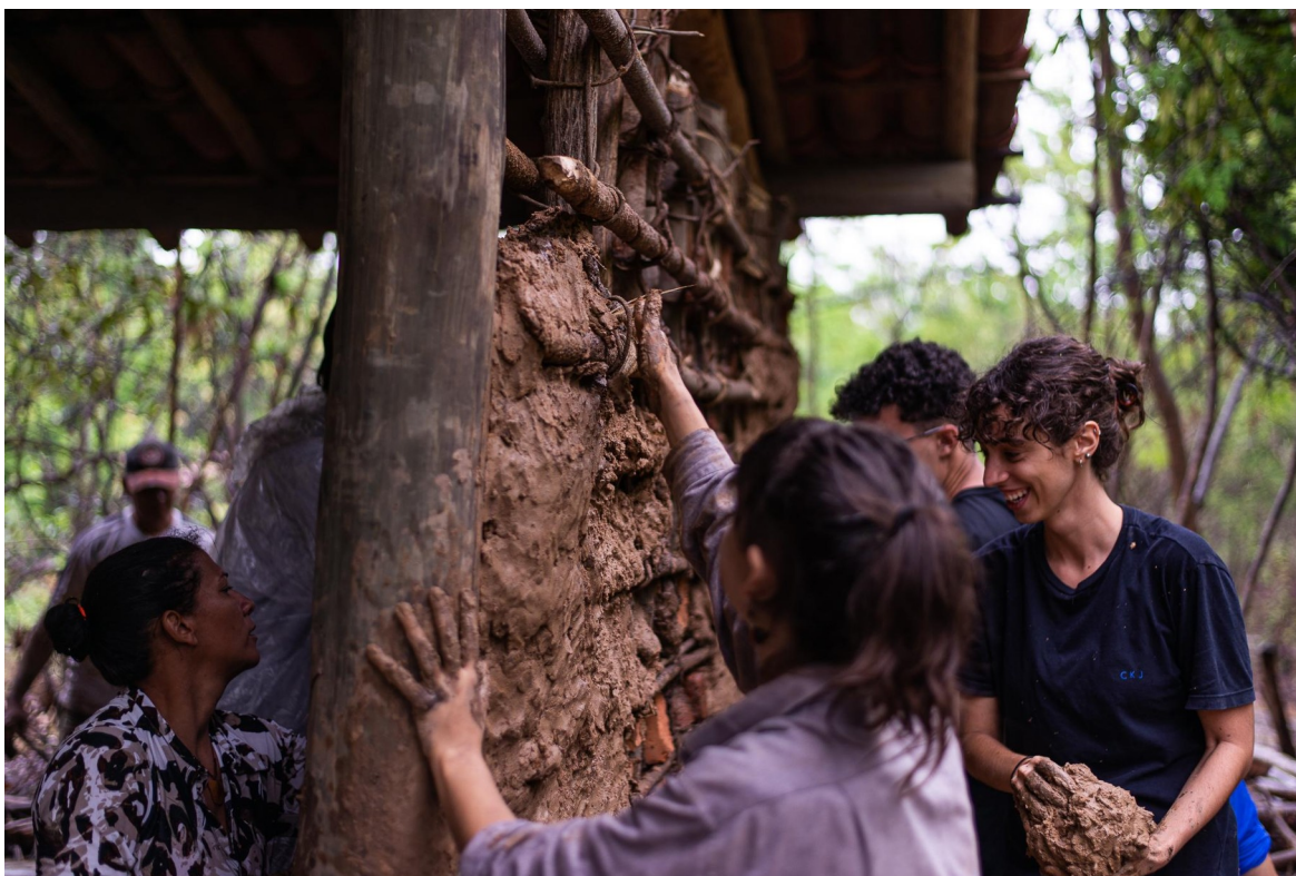
Figura 5- Construção da Parede de Enchimento - Foto de Autoria de Edgar Kanaykô.
