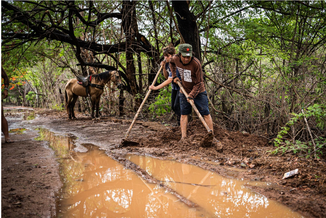
Figura 3- Abrindo a vala- Foto de Aurtoria de Edgar Kanaykõ.
