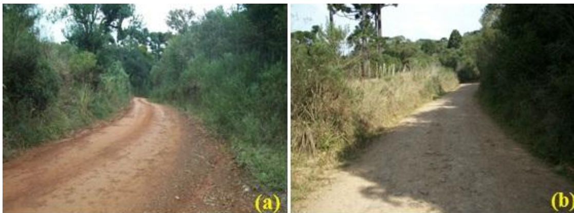
Figura 3- Características das estradas rurais da bacia do Rio Guabiroba. Em (a) estrada em solo nu, com presença de ravinas na margem direita, e em (b) estrada com cascalho na faixa de rolamento.
