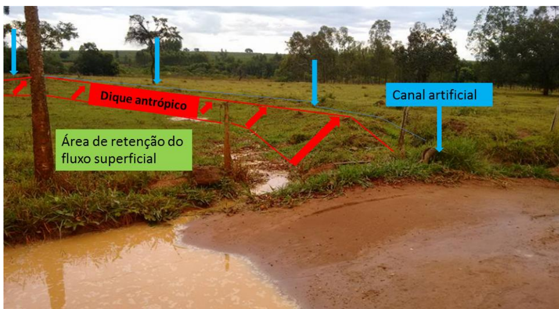
Figura 3: Em evento chuvoso é possível perceber que os diques artificiais geram uma desconexão entre os fluxos das estradas e vertentes com o canal artificial.
