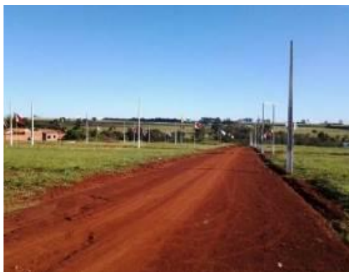
Figura 8- Loteamento em construção Canápolis-MG. Fonte: Autores (2016).
