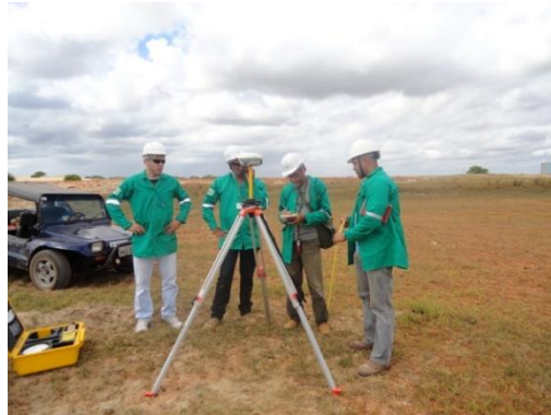
Figura 03 – Determinação das cotas absolutas dos pontos de perfis de praia, georreferenciados com GPS geodésico. Equipe de Campo. Foto: Marcelo Chaves, 2012.
