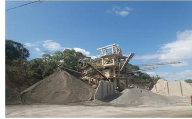
Figura 4 – Britador secundário da OCS Kibrita Mineração e Empreendimentos.
