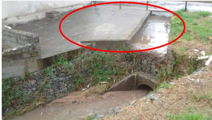
Figura 4 - Obra de direcionamento da água da chuva, junto ao muro de gabiões.
