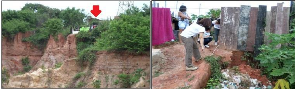
Figura 2: Área com ocorrência de movimentos gravitacionais de massa do tipo escorregamento rotacional no bairro Salinas do Sacavém
