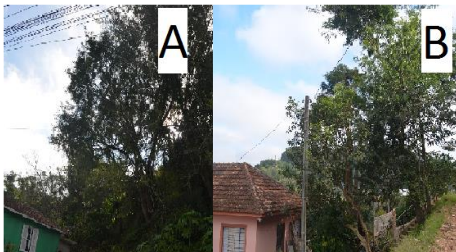
Figura 4. Moradias em situação de risco na encosta do morro Cechella, devido ao possível tombamento da vegetação arbórea.
